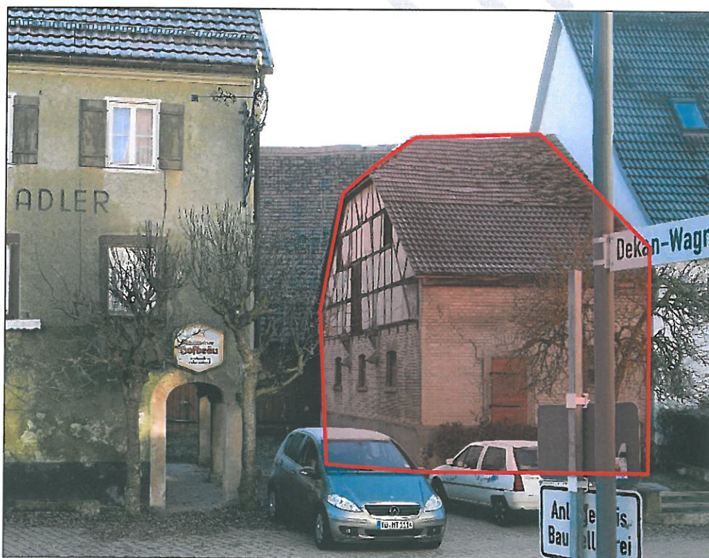
Ansicht aus nördlicher Richtung
