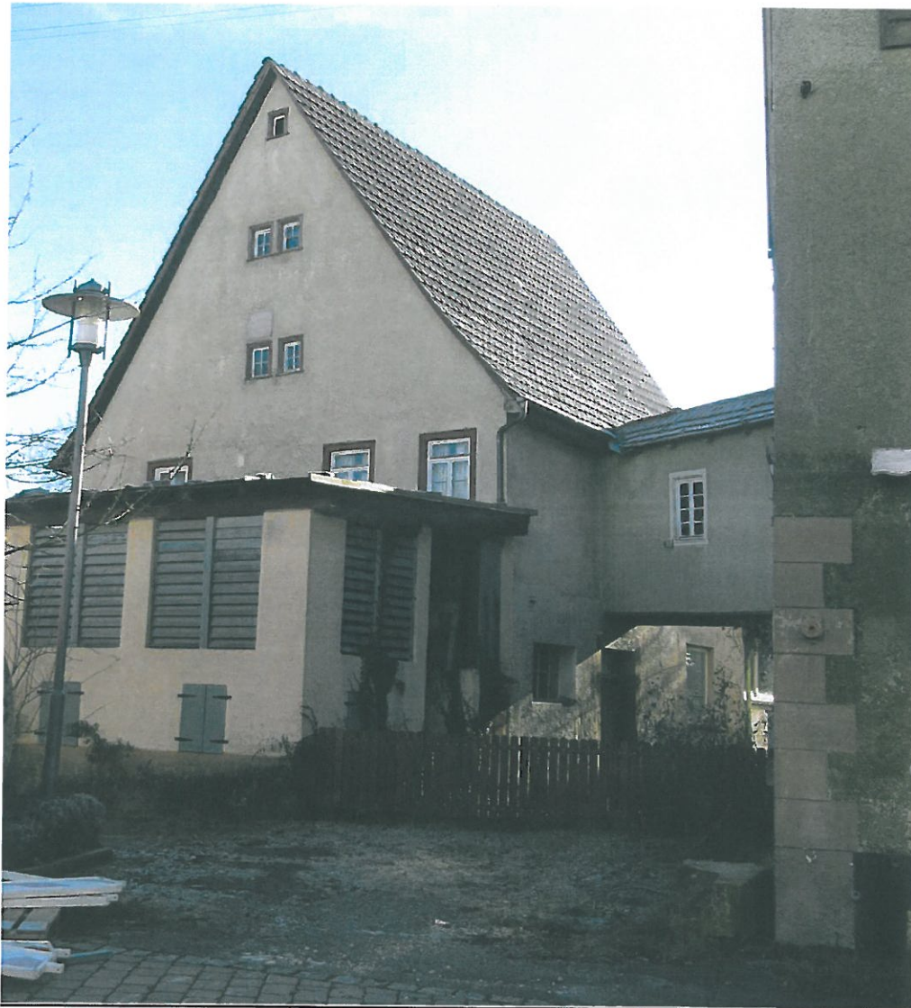
Ansicht aus nördlicher Richtung
