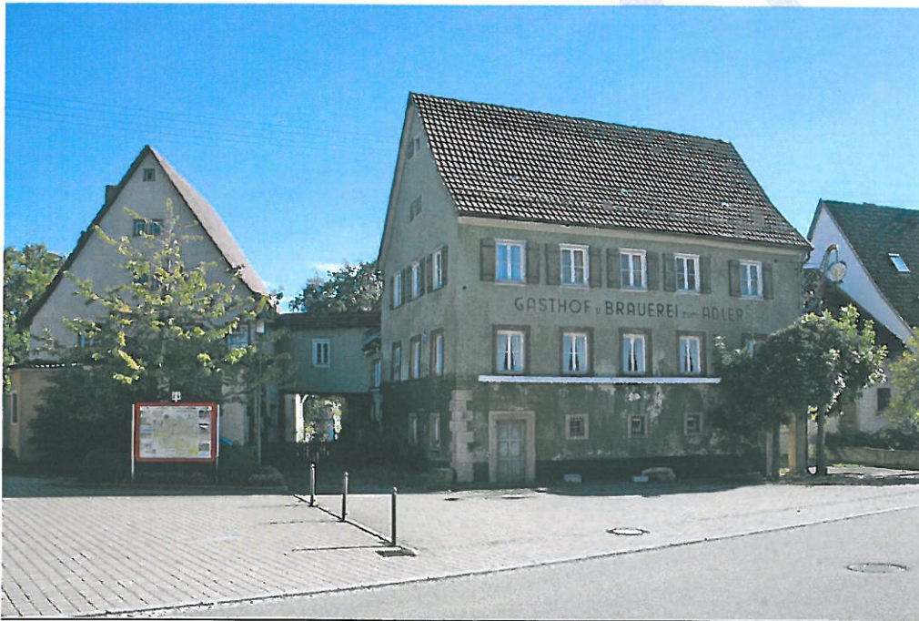
Ansicht aus nördlicher Richtung
